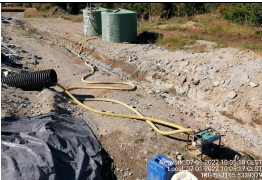
Fotografía N°9: Extracción de Lixiviados desde diagonal D03 por personal municipal. Tomada: Viernes 07 de Enero del 2022.
