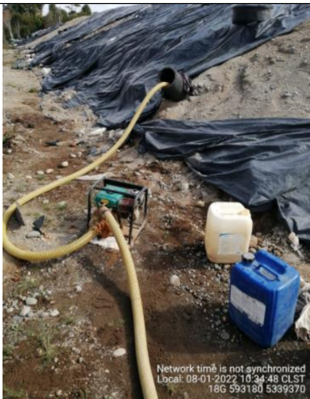
Fotografía N°11: Extracción de Lixiviados por personal municipal. Tomada: Sábado 08 de Enero del 2022.
