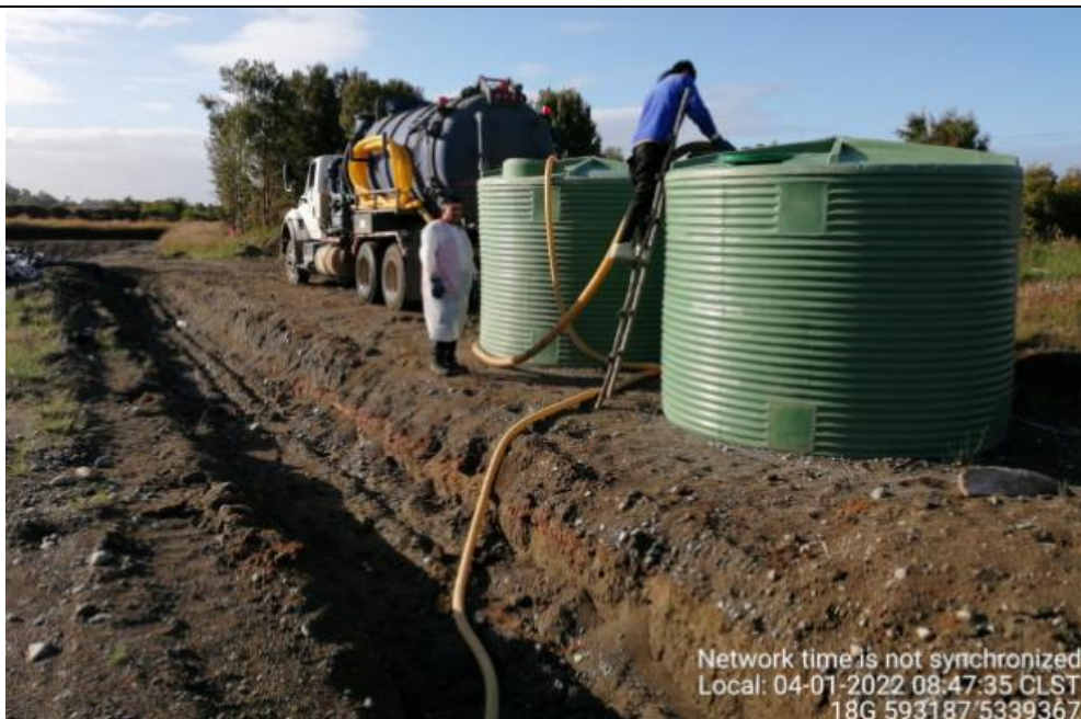
Fotografía N°4: Retiro de Lixiviados a estanque por Personal Municipal. Tomada: Martes 04 de Enero del 2022.
