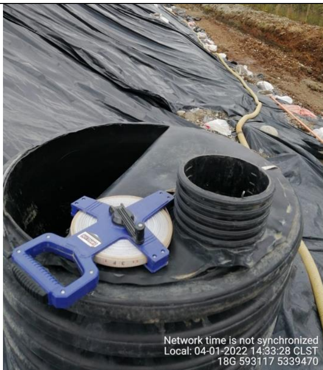
Fotografía N°13: Medición de Niveles de cámaras por Personal Municipal. Tomada: 04 de Enero del 2022.
